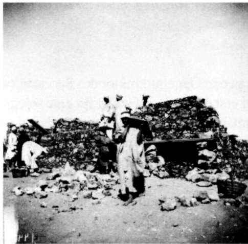
Abb. 1: Bau der „Leipziger-Hütte“
