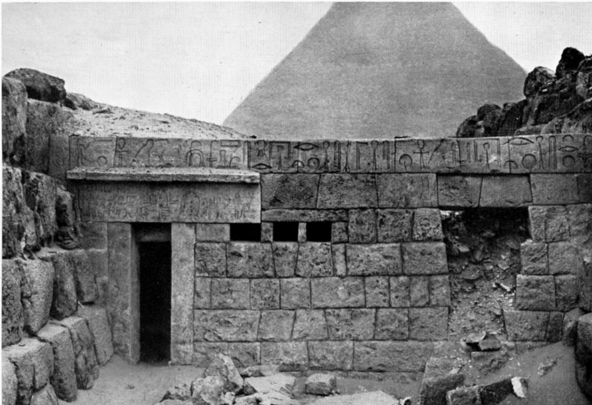
a) Oberbau: nördliche Außenfront.
