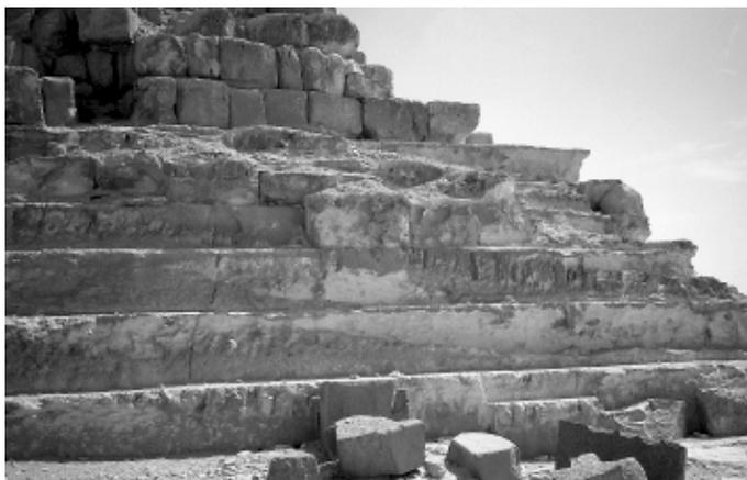
**Im Bereich der Nord-West-Ecke der Chephren-Pyramide ist der zur Aufnahme der Verkleidungsblöcke (Granite und andere Hartgesteine der unteren Lagen, Tura-Kalkstein und sogenannte »backing stones« der folgenden Lagen) stufig abgearbeitete Felskern bis zur 5. Lage in Höhe von etwas über 5 m über der Basis sichtbar.** Foto: Jürgen Becker
