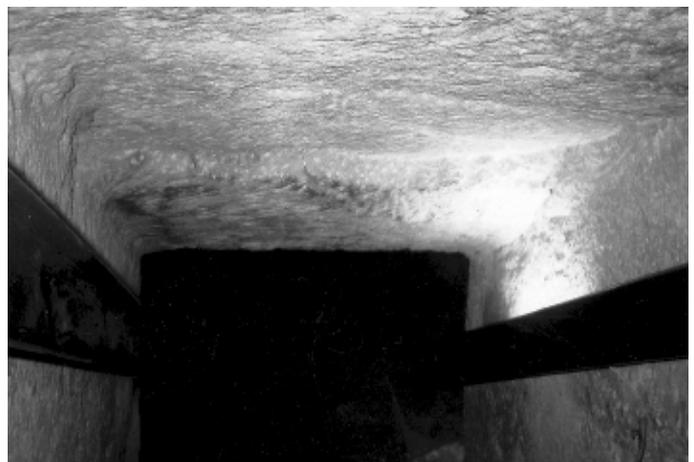
**Die kritische Stelle im Gang zur Felsenkammer: Etwa 1,50 m vor dem Kammereingang endet die nach Fertigstellung des Eingangs im letzten Abschnitt vorgenommene nachträgliche Erhöhung der Gangdecke mit einem ca. 8 cm hohen Absatz zur ursprünglichen Decke. Diese abgebrochene Korrektur wurde in Meißel-, der Gang selbst in Steinhammer-/Steinaxt-Technik ausgeführt.** Foto: Jürgen Becker
