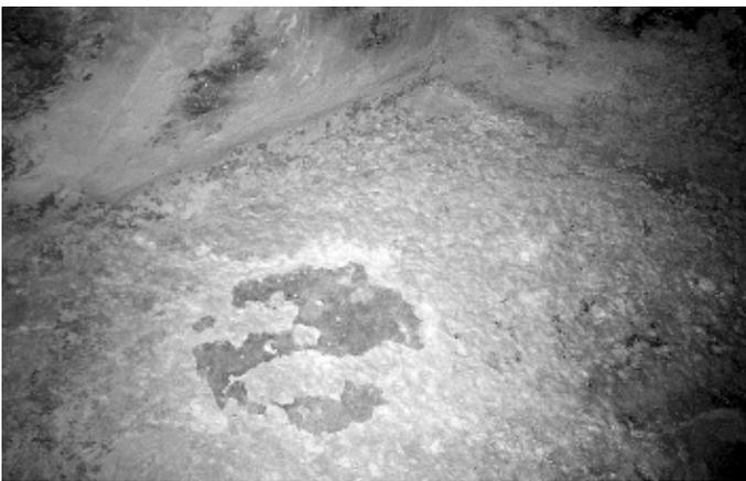
**Ein Rest des rot eingefärbten, abgewitterten Putzes an der Westwand der Felsenkammer der Chephren-Pyramide. Eine Laboruntersuchung könnte ergeben, daß dem Kalk-/Gips-Putz Rosengranit-Abrieb vom Glätten der Sockellagen der Pyramidenverkleidung beigemischt wurde. Dies könnte schlicht der Härtung des Putzes gedient haben; es wäre aber auch ein Imitat einer Granitverkleidung der Kammer in Erwägung zu ziehen.** Foto: Jürgen Becker
